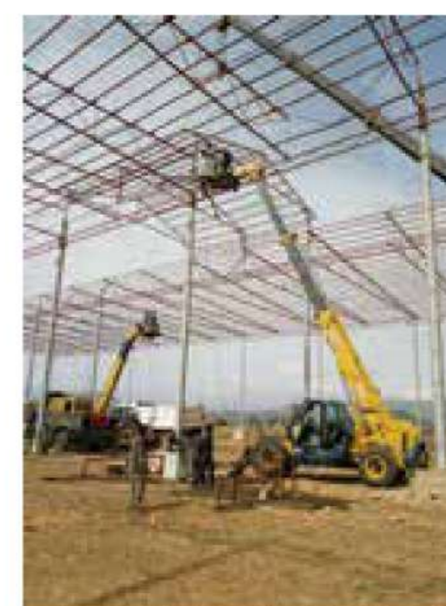
Телескопические погрузчики BEL-DOZER на строительстве стальных конструкций
